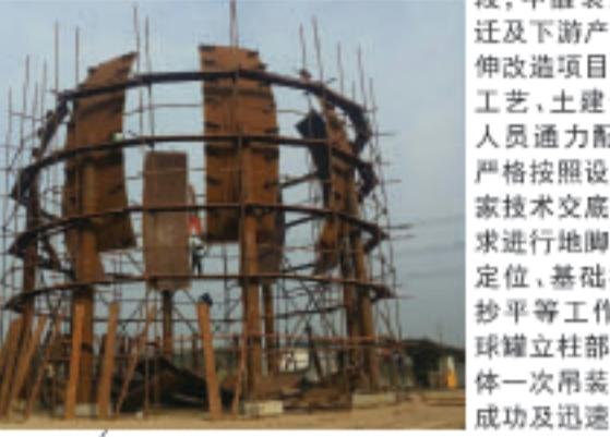
本报讯(记者 刘泽)9月10日,甲醛装置搬迁及下游产品延伸改造项目组的工艺、土建专业人员通力配合,严格按照设备厂家技术交底的要求进行地脚螺栓定位、基础模板抄平等工作,为球罐立柱部分壳体一次吊装就位成功及迅速开展壳体组对工作奠定了坚实基础。
