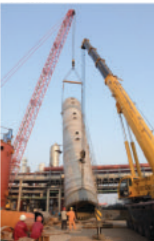
更换做到全过程监督。本次大修共进行专项质量检查45次,查出问题300余项,涉及运转设备安装、焊接、内件安装等多项内容。对大修期间车间提出现场检查问题的要求,及时安排人员到现场进行光谱检测,保证了车间的检测需求,为开车后高效运行和长周期运转奠定了坚实基础。
